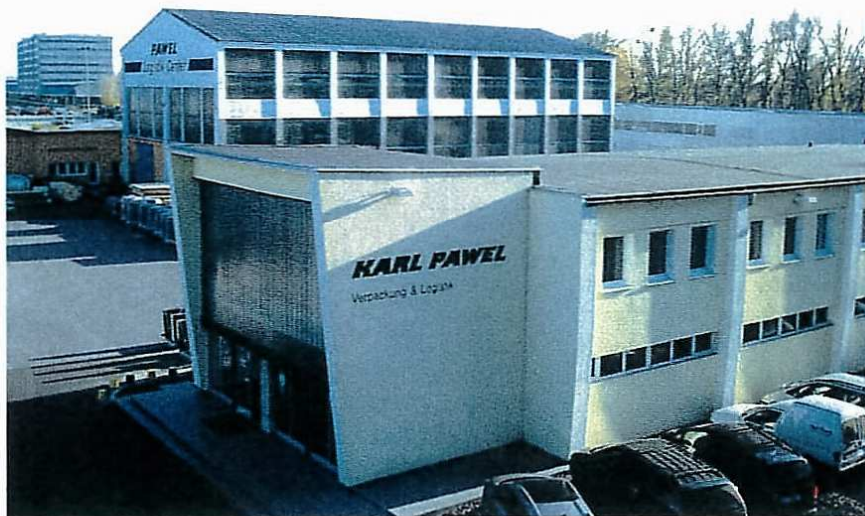
Blick auf den Standort der Firma Pawel in der Hellingsstraße 2 am Hafen Freudenau (Fotos: Pawel)
